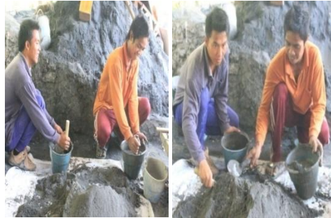
Gambar : Proses Penyampuran pasir Melela dengan Semen Sumber :Dokumentasi Pribadi
